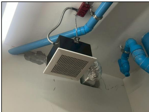
ภาพที่ 2-41 พัดลมดูดอากาศในห้องพักขยะ
