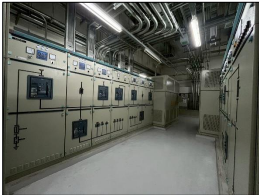
ตู้ควบคุมระบบไฟฟ้าหลัก (MDB)
